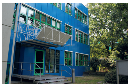
Après Esthétique et protection pour les vingt prochaines années
